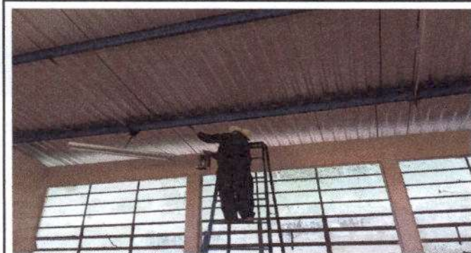
Foto 3: Mantenimiento a estructura de soporte de metal
