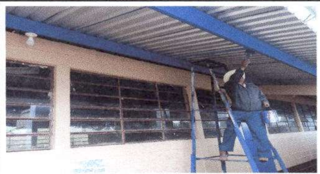
Foto 4: Mantenimiento a estructura de soporte de metal
