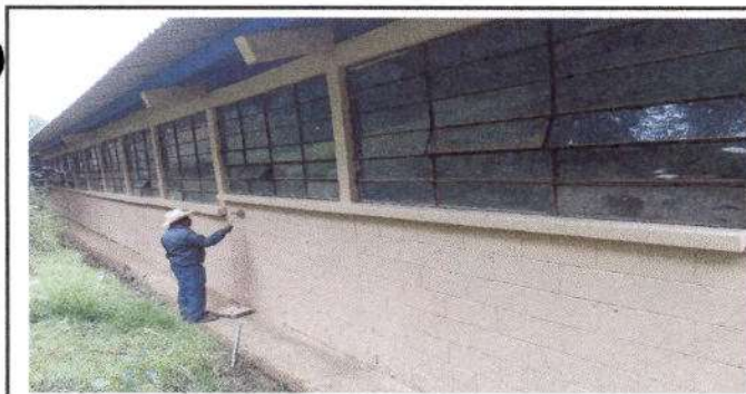
Foto 5: Pintura en muros exteriores e interiores
