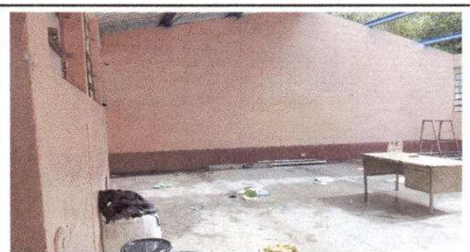
Foto 6: Pintura en muros exteriores e interiores
